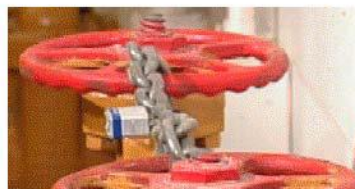
Bloqueo de válvulas
