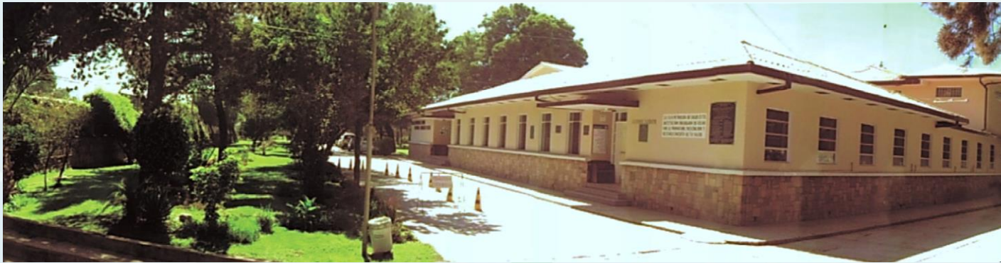
Hospital Elizabeth Seton (Construido en el año 1968)
