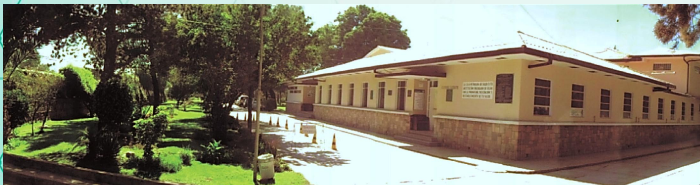
Hospital Elizabeth Seton (Construido en el año 1968)
