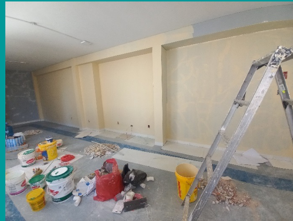
RENOVACION PINTURA EN PAREDES Y REPARACION SISTEMA ELECTRICO
