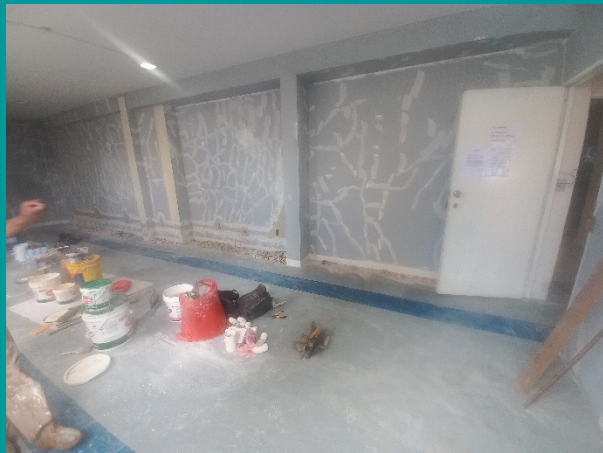
RENOVACION PINTURA PAREDES
