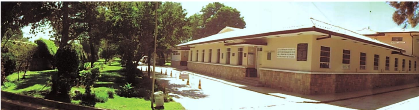
Hospital Elizabeth Seton (Construido en el año 1968)
