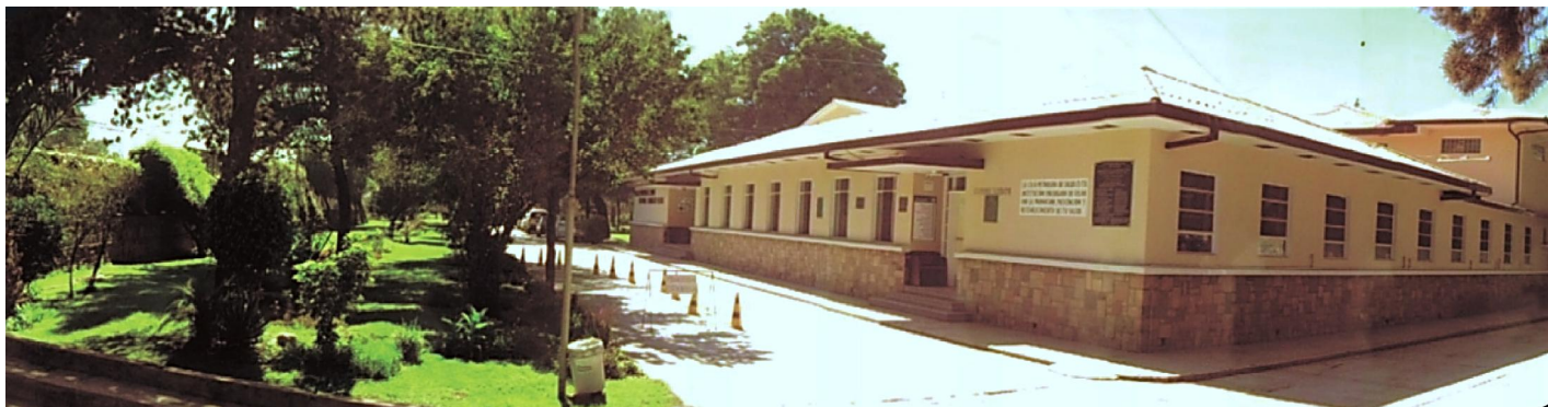
Hospital Elizabeth Seton (Construido en el año 1968)
