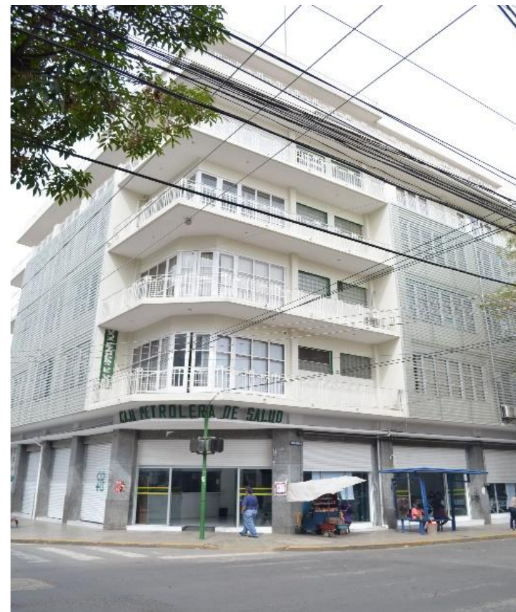
Policlínico Central (Construido el año 1952)
